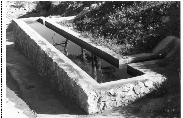
Foto VI. Abrevadero de nueva construcción. Azuébar.
